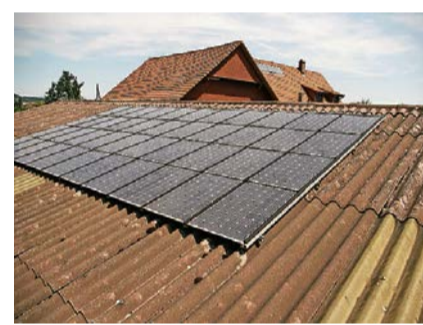
25-jährig: Anlage in Hettlingen (ZH).
